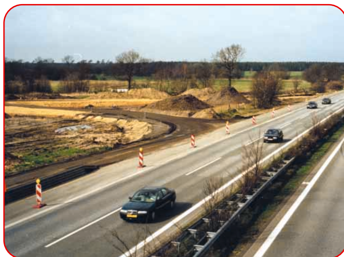
(3) Der Autobahnzubringer Henstedt-Ulzburg an der A7
